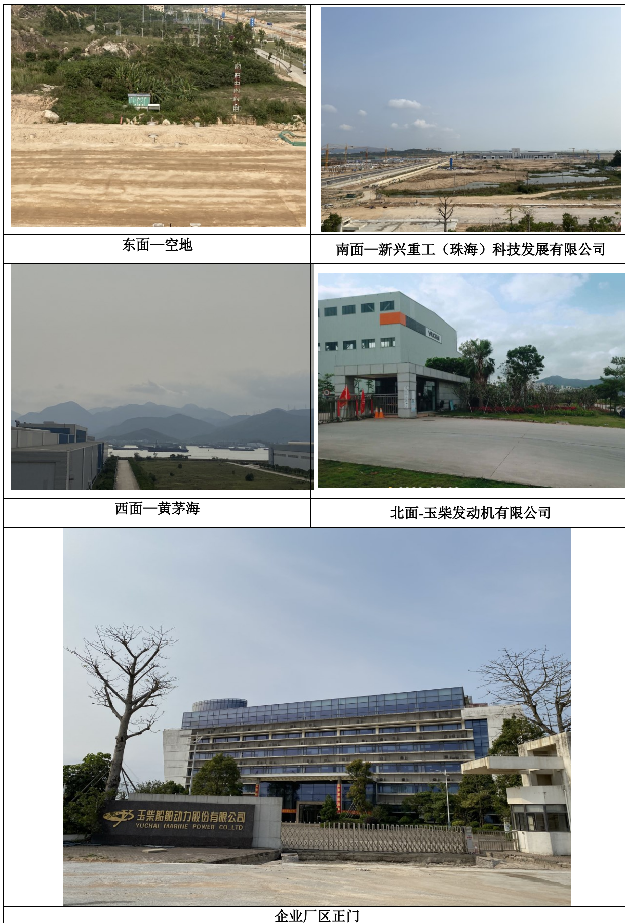
图 3.1-3 建设项目四至实景图
